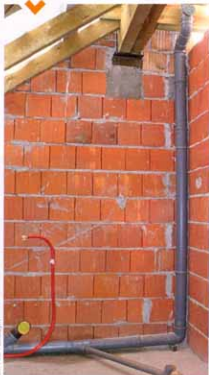
■ ...jeśli podejście do niej jest dłuższe niż 1 m, trzeba wykonać jego napowietrzenie (najlepiej tak jak na zdjęciu – rurą wyprowadzoną nad dach)
