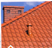
■ Pion kanalizacyjny wyprowadzony na zewnątrz i zakończony wywiewką dopasowaną do rodzaju pokrycia dachu
