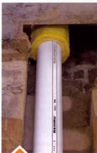
1 Owinięcie rury wełną mineralną w miejscu przejścia przez strop. Taka izolacja zapobiega przenoszeniu się hałasu z kanalizacji na ściany i stropy
