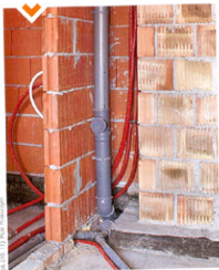
Fig. 10. 11) Rura Powietrzna
