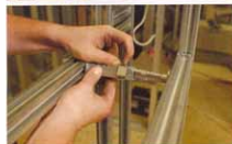
8, 9. Do przetrzynanego usztywnienia stelażu służą inne łączniki o regulowanej długości.
