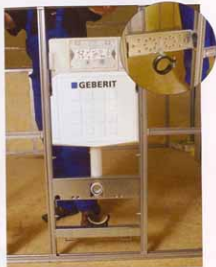
3. W ruszcie konstrukcyjnym zamocowane już były wszelkie uchwyty potrzebne do montażu przewodów instalacyjnych (łącze ze spłuczką).
