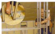
8, 9. Do przetrzynanego usztywnienia stelażu służą inne łączniki o regulowanej długości.
