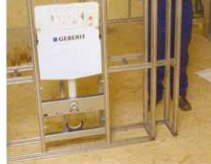
12. Po dokładnym wyprofilowaniu ruszta konstrukcyjnego, zmontowany stelaż trzeba zamocować do podłoża za pomocą łączników kątowych.
