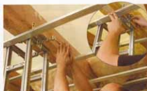
10, 11. Mrozoodporny zacisk umożliwia bardzo wygodny i szybki montaż stelaża, ale wymaga otwiera nieco większą siłę. Z tego względu warto poszukać się odpowiednim narzędziem np. regulowanym kluczem.
