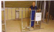
1, 2. Skielet ścianki instalacyjnej został częściowo prefabrykowany i na budowie trzeba było jedynie ustawić i połączyć ze sobą poszczególne elementy.
