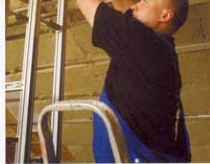
13. W domu pasywnym oba słupki ruszta dodatkowego zostały przykryte do drewnianych żłęk wieżby dachowej.
